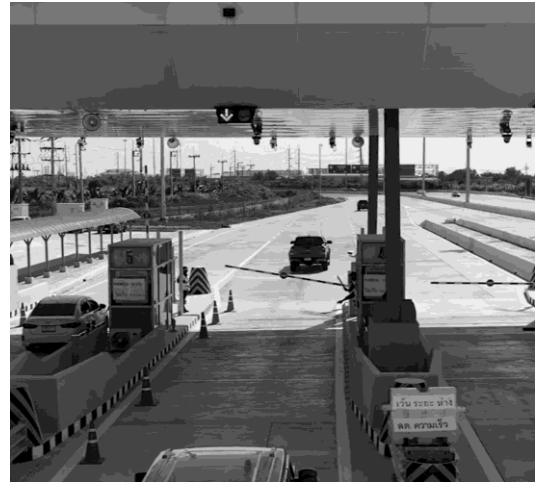
รูปที่ 6-16 ระบบเก็บค่าธรรมเนียมผ่านทางแบบอัตโนมัติ ETC M-Pass / Easy Pass
